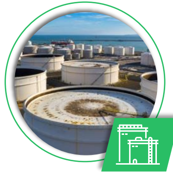
LNG / Tank Terminal
