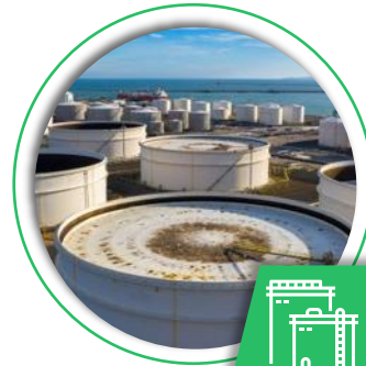
LNG / Tank Terminal
