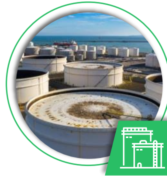
LNG / Tank Terminal
