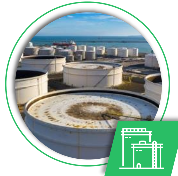
LNG / Tank Terminal
