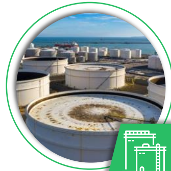
LNG / Tank Terminal
